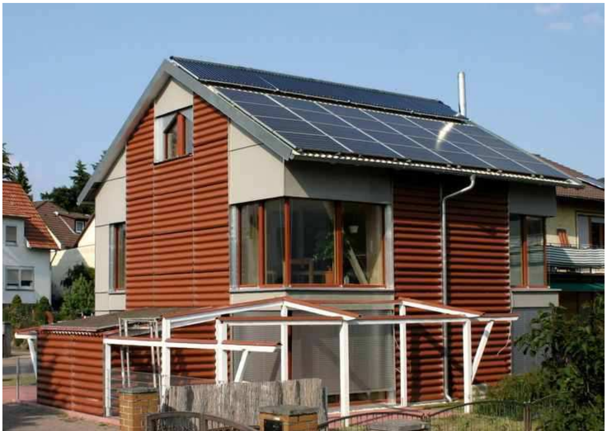
Passivhaus im Rhein-Main-Gebiet mit Photovoltaikanlage ©Passivhaus Institut
